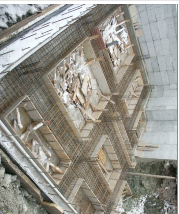
CANTIERE : ARMATURA FONDAZIONI
