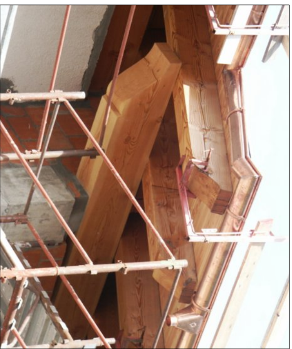
CANTIERE : PARTICOLARE DEL TETTO
