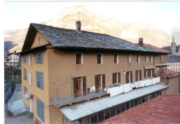
Stato precedente ai lavori
