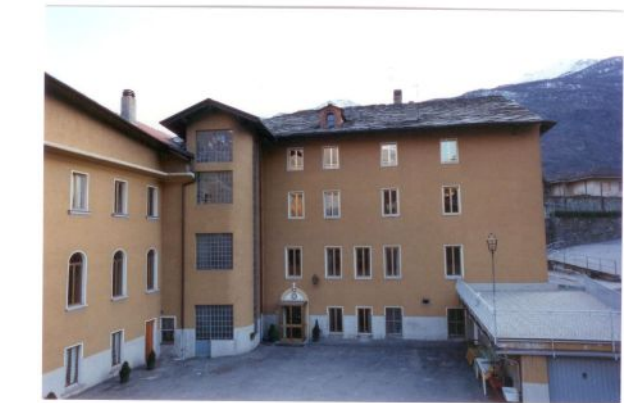
Stato precedente ai lavori – ingresso struttura e cortile interno
