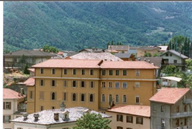
Stato precedente ai lavori – lato est
