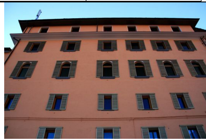
Lato est su strada comunale Via Martiri della Libertà dopo l'intervento di riqualificazione esterna
