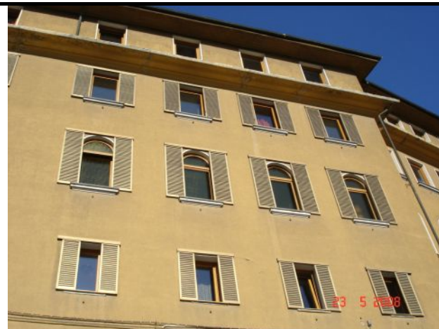
Lato est su strada comunale Via Martiri della Libertà – stato precedente ai lavori
