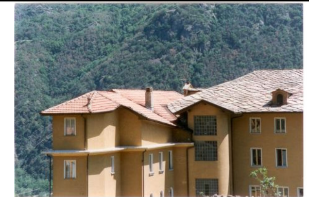
Stato precedente ai lavori
