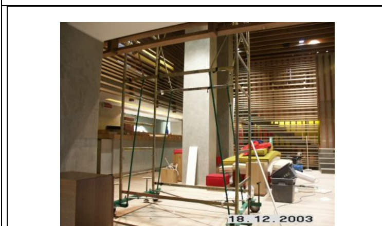
Lavori di allestimento dell'arredo interno
