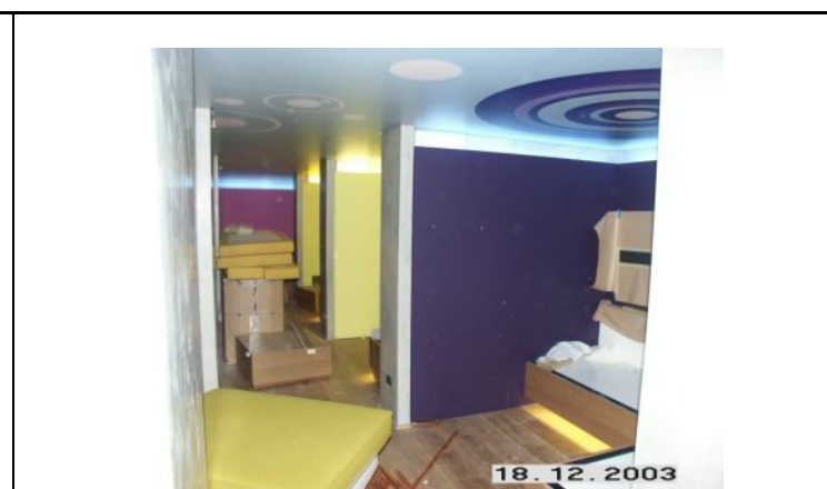
Lavori di allestimento dell'arredo interno
