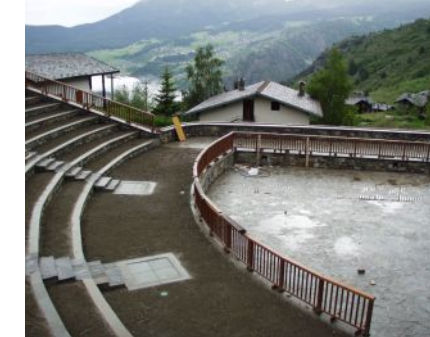
Realizzazione delle gradonate
