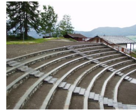
Realizzazione delle gradonate
