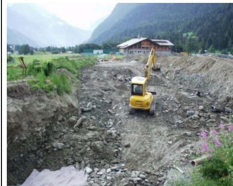
Fase di scavo
