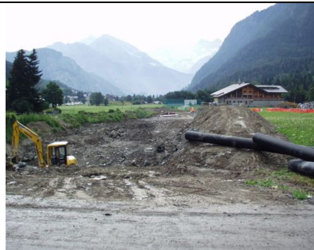
Fase di scavo
