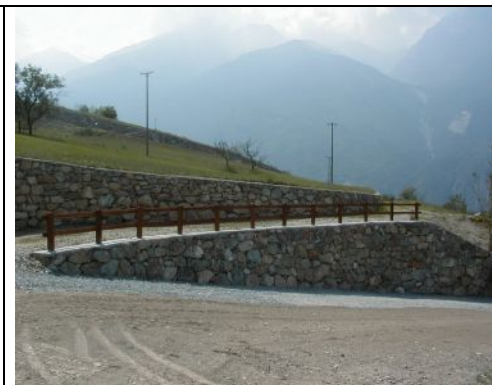
Vista di una delle piste di collegamento
