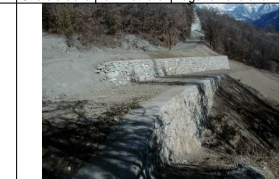
Vista di una delle piste di collegamento
