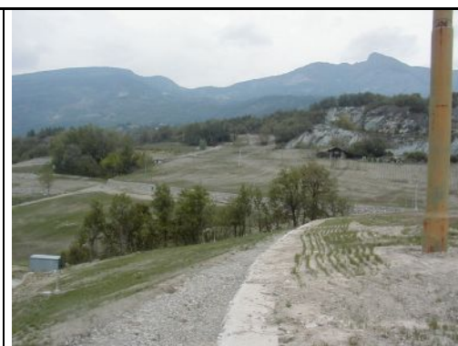
Vista degli interventi in fase di ultimazione dei lavori
