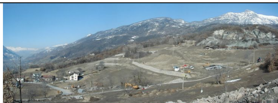
Vista generale degli interventi durante la fase di esecuzione
