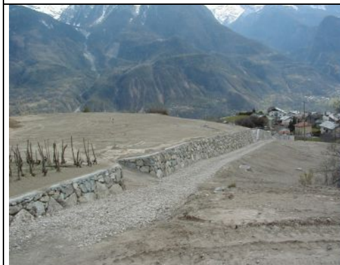
Vista di una delle piste di collegamento
