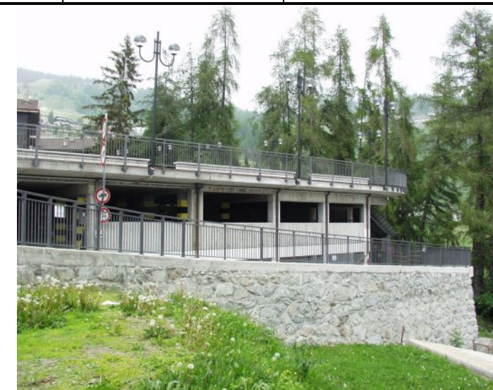
Vista dell'autorimessa interrata – zona a sud-est
