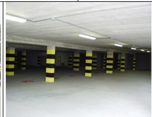
Interno dell'autorimessa interrata
