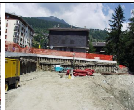
Predisposizione del piano per la realizzazione del 2° ordine di tiranti
