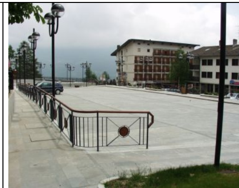
Vista della Piazza – lato ovest
