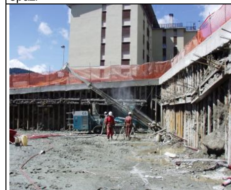
Perforazione per la realizzazione dei tiranti del 2° ordine
