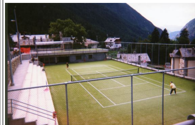
Il tetto piano più alto ospita il campo da tennis, a raso delle gradinate sulla sinistra vi è la strada comunale per Crétaz
