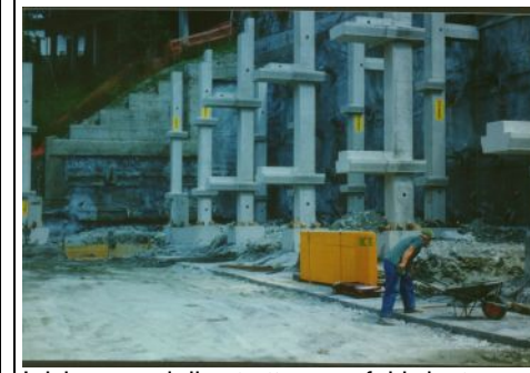
Inizio posa della struttura prefabbricata
