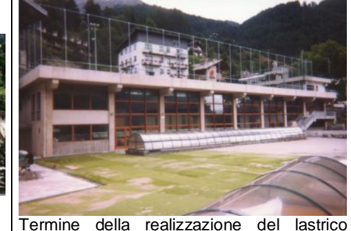
Termine della realizzazione del lastrico solare antistante la piscina coperta
