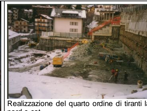
Realizzazione del quarto ordine di tiranti a valle della strada comunale
