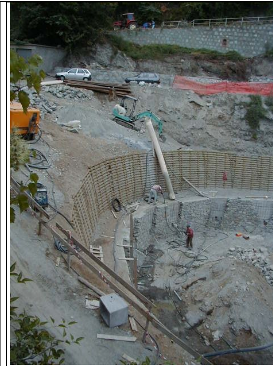
Consolidamento del pendio a valle della strada
